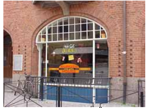
CARL 2 A från N SKYLTFÖNSTER
