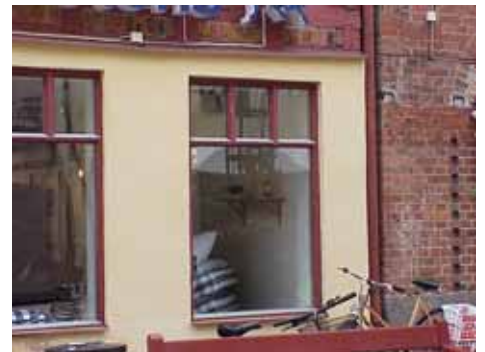
CARL 1 A från N SKYLTFÖNSTER
