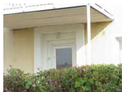
VASSEN 3 A från SV DÖRRUMFATTNING
