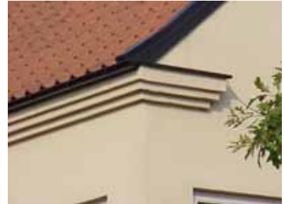
VASSEN 4 från S GESIMS
