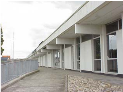
ÖSTERPORTSHALLEN från V DETALJ juli 2007
