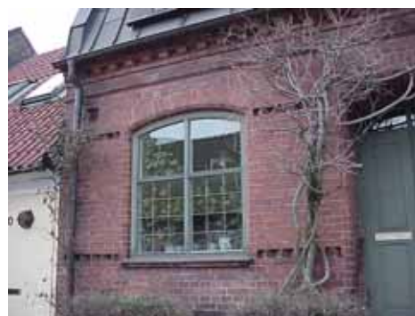
MÅRTEN 6 från S FÖNSTER
