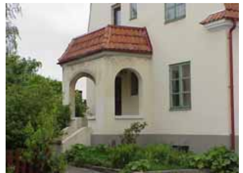
BUSKAMÖLLAN 7 A från SO VERANDA
