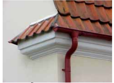
BUSKAMÖLLAN 7 A från SO GESIMS
