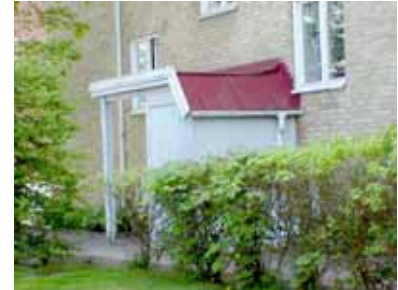
BOKEN 3 A från NV GÅRDSENTRÉ
