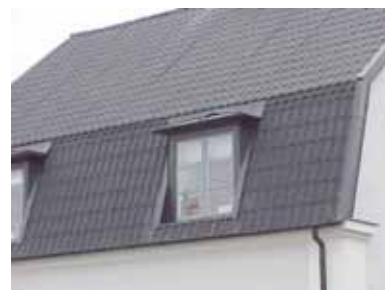
GULLIN 9 A från NO MANSARD-FÖNSTER
