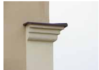
GULLIN 2 från N GESIMS
