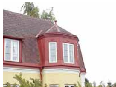
GULLIN 1 från N TORN
