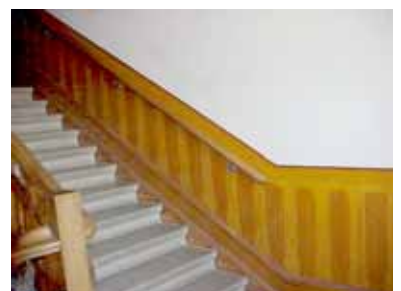
KORPEN 7 A TRAPPHUS ÅD- RINGSMÅLNING
