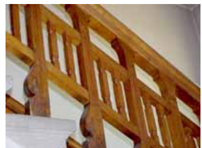
KORPEN 7 A TRAPPHUS RÄCKE
