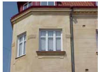
KORPEN 7 A från S FÖNSTER
