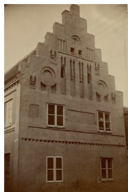
Den vackra sydgaveln är överputsad och bilderna i blindingarna är borta. Bilden från 1875.
