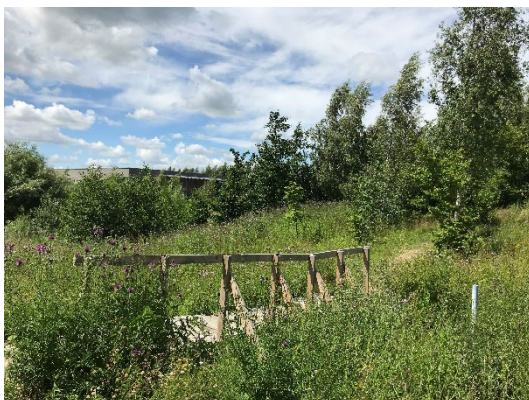
Damm från sydost med butiksbyggnad i bakgrunden
