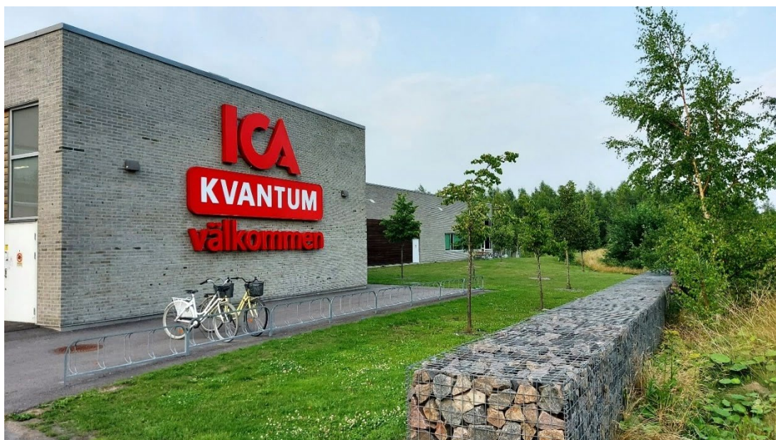
Befintlig byggnad från sydväst och område för planerad tillbyggnad
