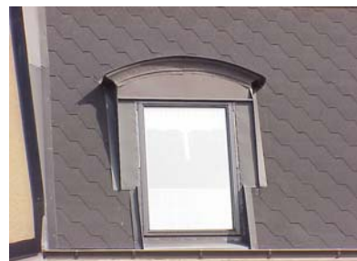
TRÄGÅRDH N. 1 A från V MANSARDFÖNSTER
