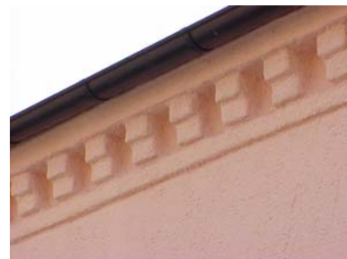
TRÄGÅRDH N. 7 A från NV, GESIMS
