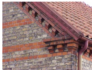
TRÄGÅRDH S. 1 C från NV, GESIMS
