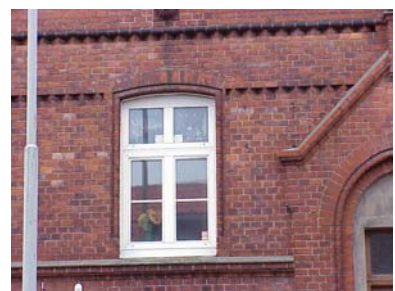
WIHLBORG N. 4 A från N FÖNSTER
