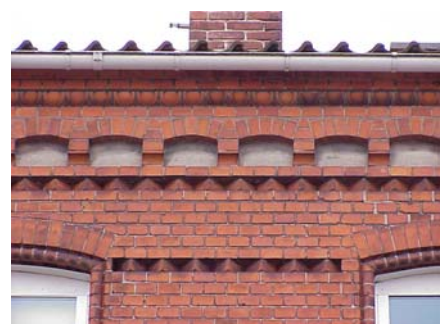
WIHLBORG N. 4 A från N GESIMS
