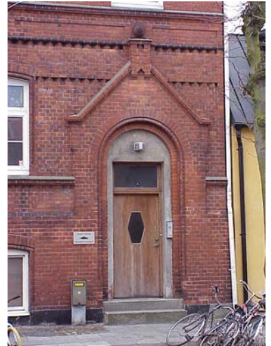
WIHLBORG N. 4 A från N PORTAL
