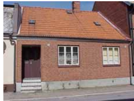
BACKUS SÖDRA 2 från SO
