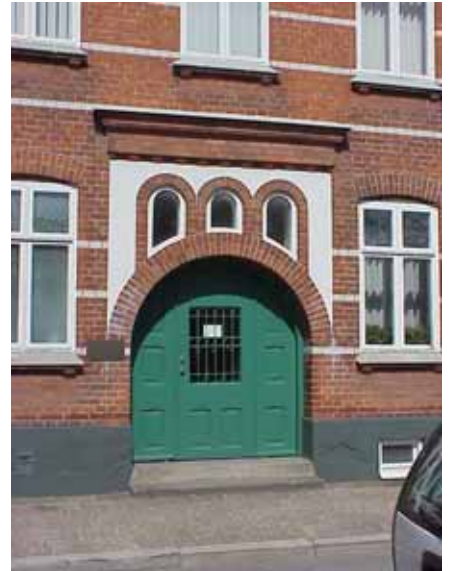
BACKUS SÖDRA 5 från SO PORT
