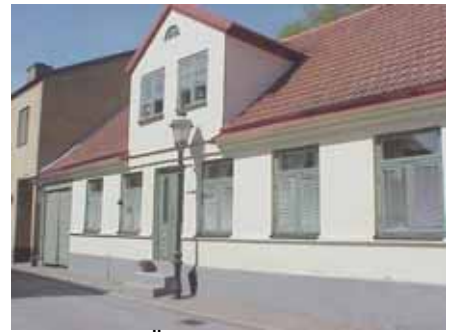
BACKUS SÖDRA 21 A från O
