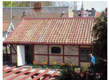
BACKUS SÖDRA 21 B från S
