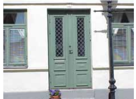
BACKUS SÖDRA 21 A från SO DÖRR
