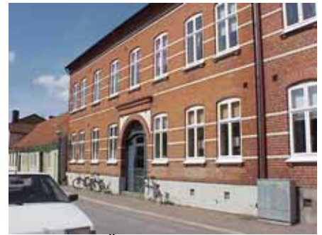
BACKUS SÖDRA 8 A från O
