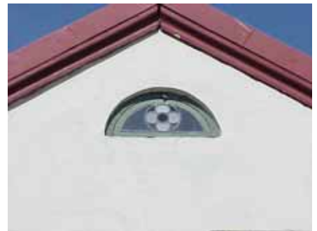
BACKUS SÖDRA 21 A från SO FÖNSTER
