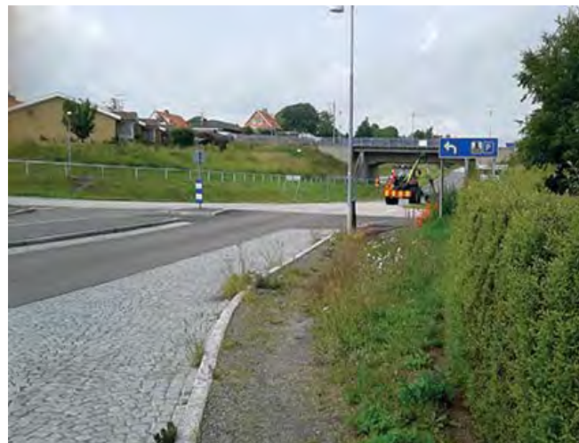
Trottoar saknas vid Balkåkravägen.
