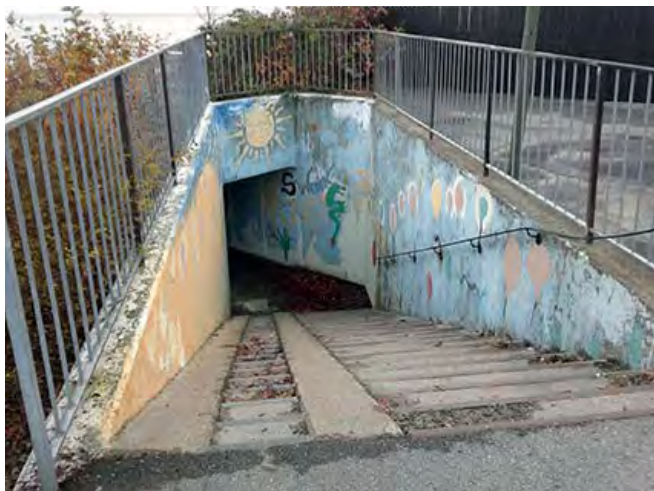
Gångtunneln under Kustvägen sedd från norr.
