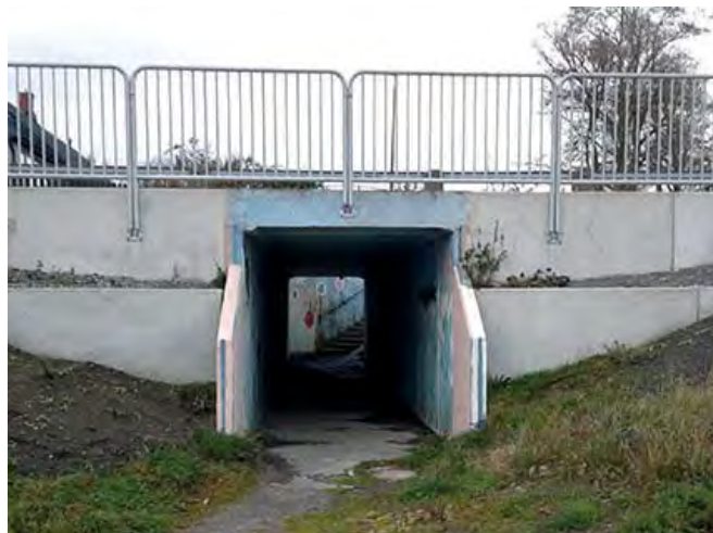
Gångtunneln under Kustvägen sedd från söder (stranden).
