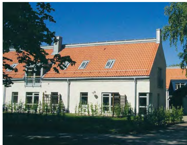
Exempel på marklägenheter från Skanör. Arkitekt och foto: FFNS Arkitekter
