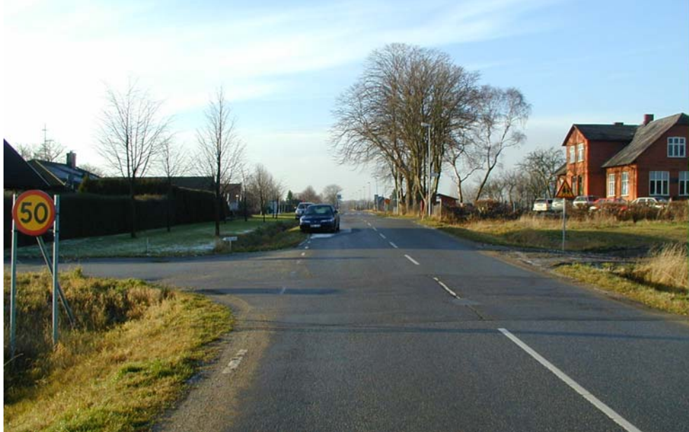
Skönadalsvägen, strax väster om korsningen med Balkåkravägen.
