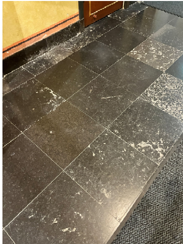
Exempel på bevarad fast inredning i bottenvåningens entréer, gångar och trapphus. Golv och sockel av komstadkalkstenen, en typ av kalksten som endast återfinns i Komstad utanför Gärsnäs på Österlen
