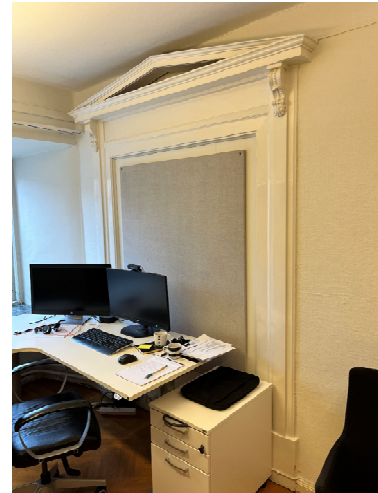
Exempel på bevarad fast inredning i bottenvåningens kontorsrum. Portalomfattning med snidad konsol och överliggande tympanonfält.
