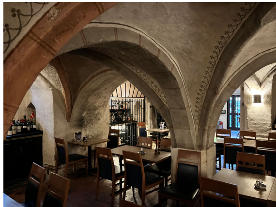
Rådhuskällaren. Bevarad kryssvalvslagning med kalkfärgsbemålade polykroma ytskikt.
