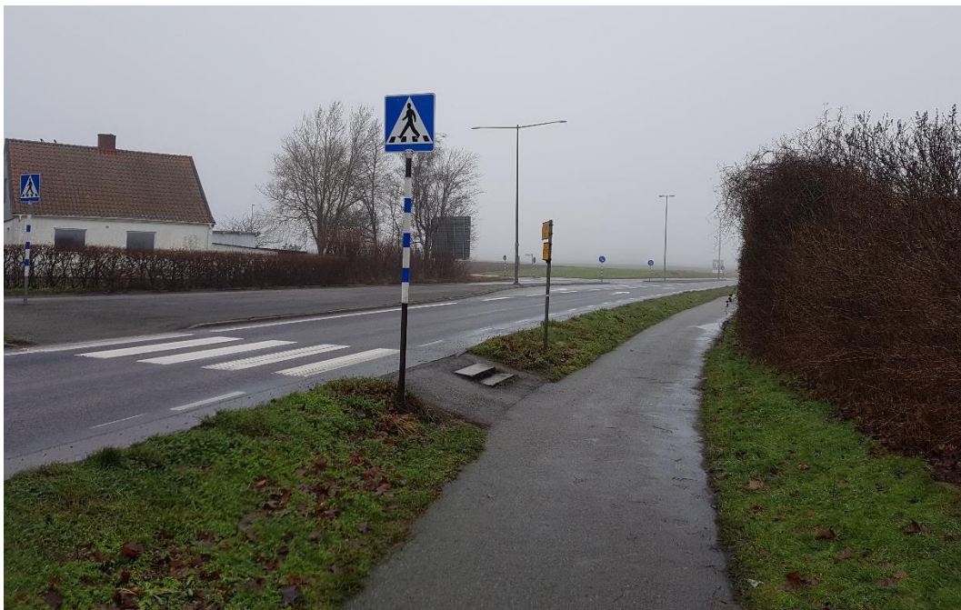
Figur 12. Nivåskillnad mellan övergångsställe och gång- och cykelbanan längs väg 19 i höjd med Emmytorpsvägen.
