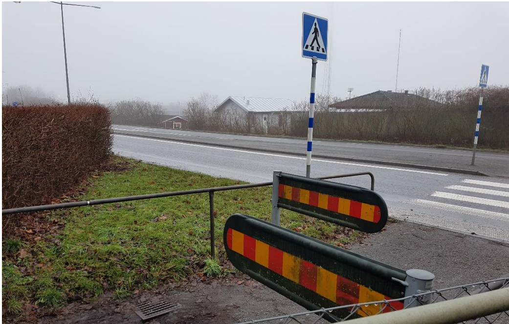
Figur 9. Begränsad sikt vid övergångsstället över väg 19 vid Emmytorpsvägen.
