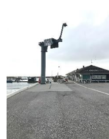
Kran och spolplatta (C)
