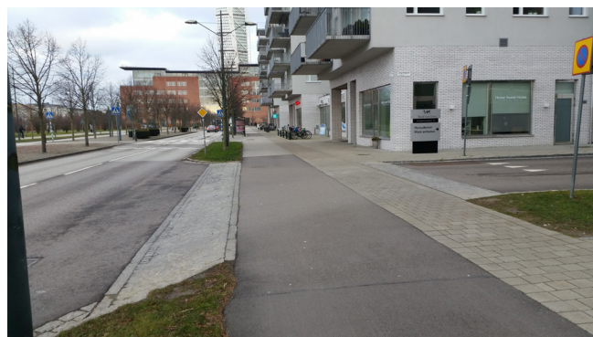
Figur 28. Genomgående gång- och cykelbana över utfart, exempel från Västra Varvsgratan i Malmö.
