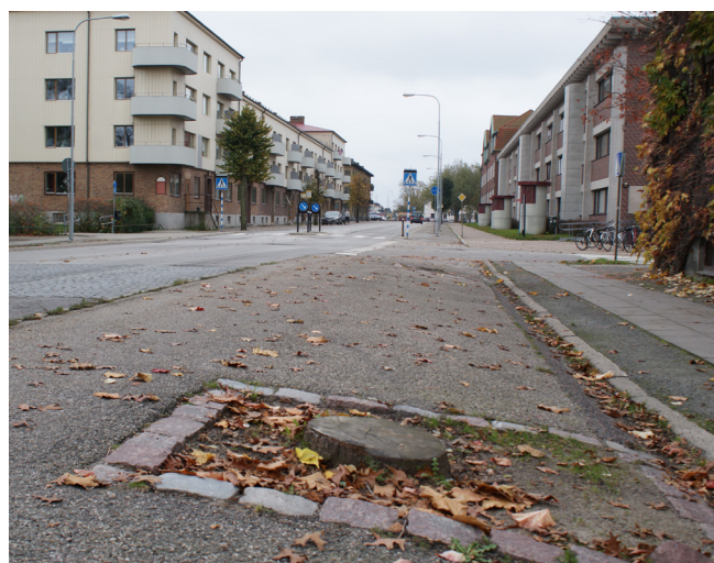
Figur 17. Exempel på hinder och komfortstörande beläggning längs Surbrunnsvägen, Ystad.
