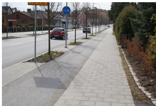
Figur 25. Separering mellan fotgängare och cyklister med hjälp av olika beläggning (Kristianstadsnågen i Ystad).
