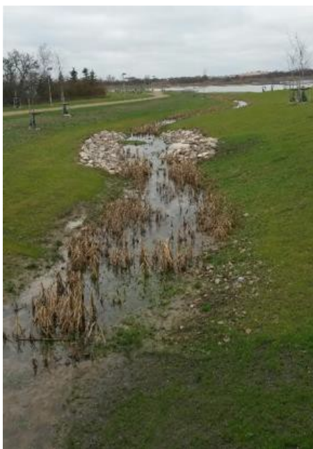
Figur 9 Svackdike. (Källa: Tyréns)
