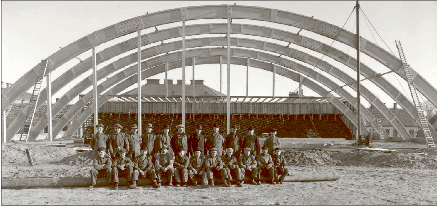
”Bollen” av byggnadsteknikhistoriskt värde.
