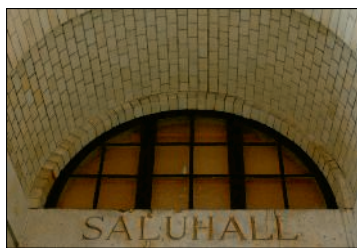
Byggnadens namn inhugget i fasaden.
